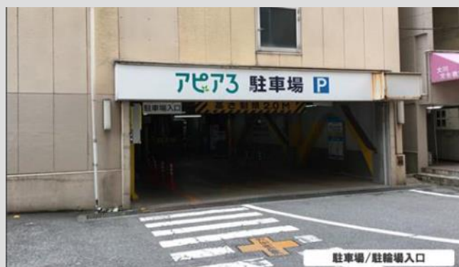
↑↑駐輪場提携駐車場入り口 外観
